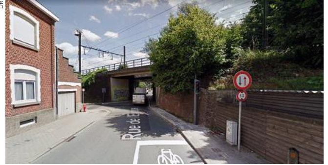
Le pont ferroviaire à Limelette, rue de l'Europe.
